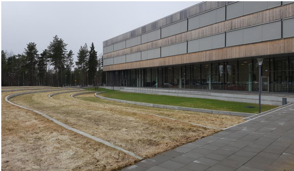
Figur 21: Minervaskolans dagvattenmagasin.
