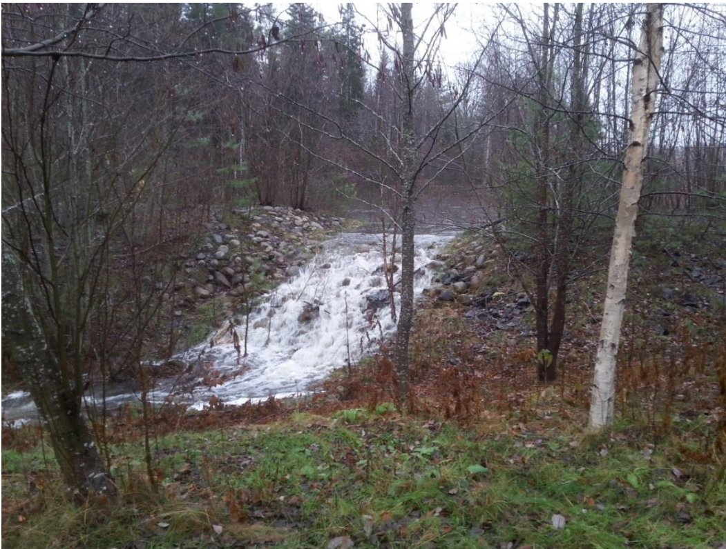
Figur 4: Bräddutloppet ur Olofsdalsmagasinet vid ett lågintensivt, men långvarigt regn
