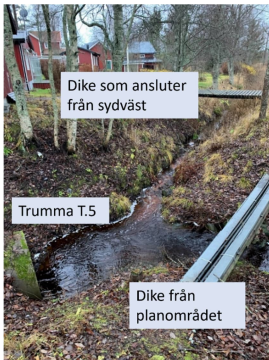
Figur 13. Där diket från sydväst ansluter till diket som avvattnar västra planområdet strax före trumma 5. Källa: Tyréns Sverige AB, 2022.
