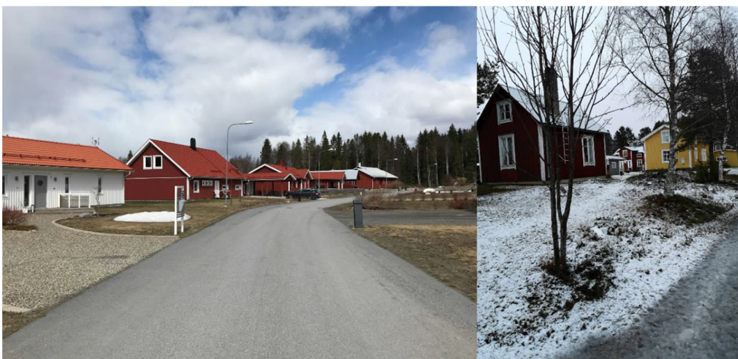
Figur 2. Befintlig bebyggelse i anslutning till planområdet (nyare tv och äldre th). Källa: Tyréns Sverige AB, 2022.
