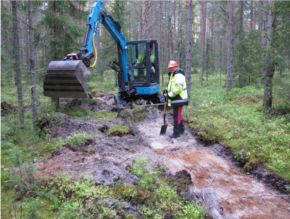
Bild 1. Berit Andersson övervakar schaktning.
