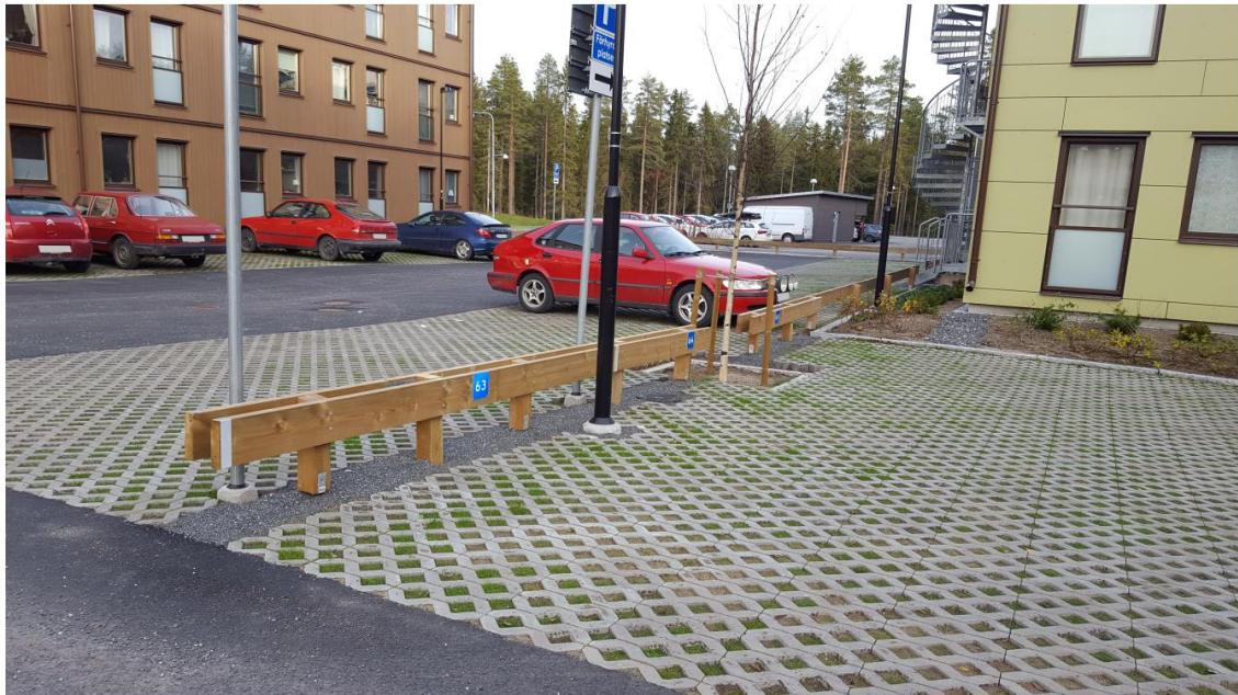
Figur 16. Bilden visar parkering utförd med genomsläpplig beläggning, s.k. armerat gräs, fotot är taget på angränsande fastighet söder om Glaciärgatan på Lilljansberget. (Tyréns 2017)
