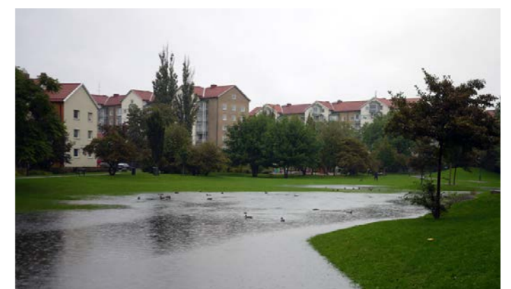
Exempel på torrdamm från Augustenborg i Malmö. Övan är dammen torrlagd, vilket den är större delen av året. Nedan illustrerar samma plats efter ett skyfall.
