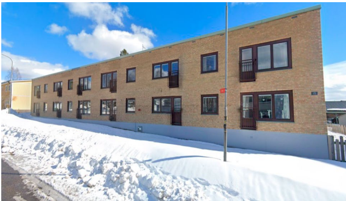
Figur 12. Fasad mot Hyggesvägen i tidstypiskt 1970-tals tegel, huvudbyggnad
