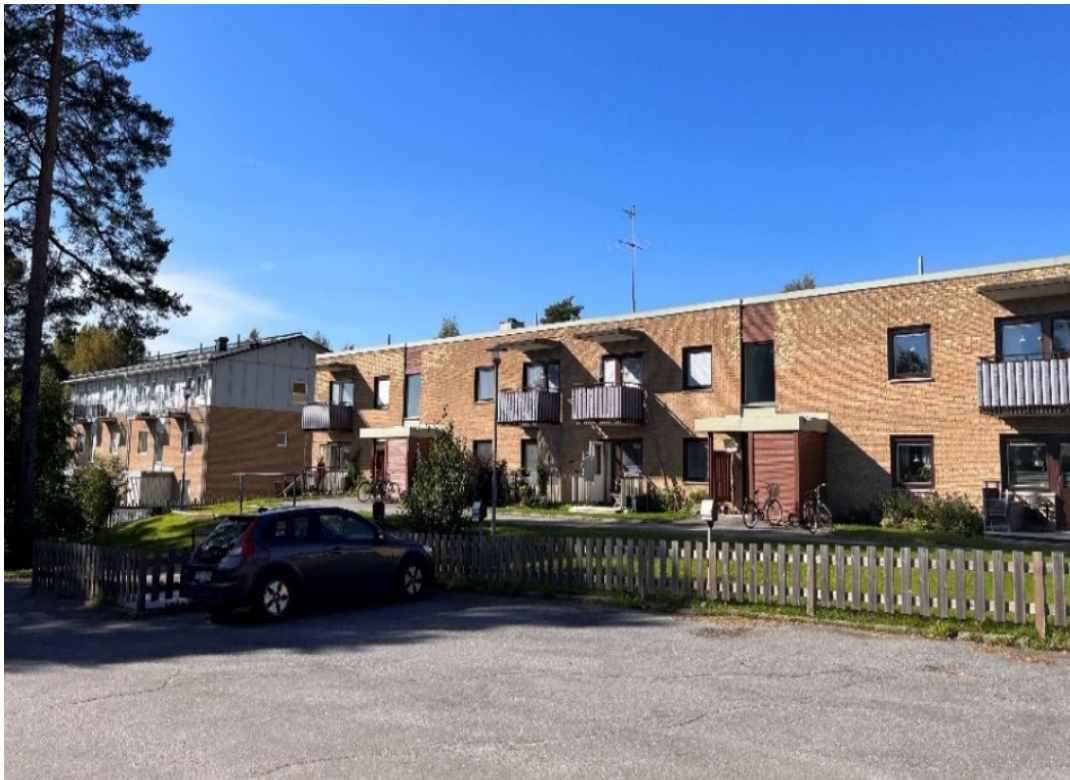
Figur 9. Huvudbyggnad för fastigheten Vindfället 9 sedd från fastighetens parkering
