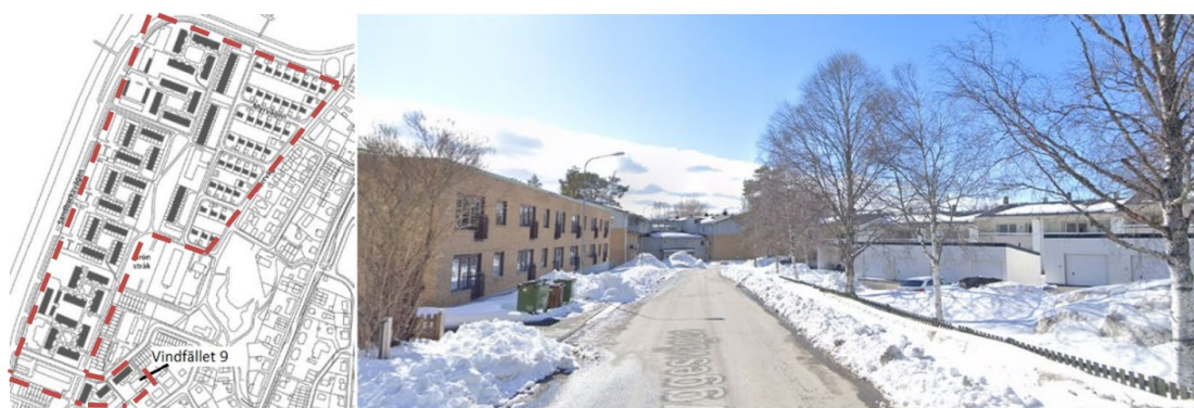
Figur 10. Fastigheten Vindfallet 9 (Tegelbyggnad till vänster i fotot) i förhållande till den samlade kulturmiljön kallad Sandabrånet.
