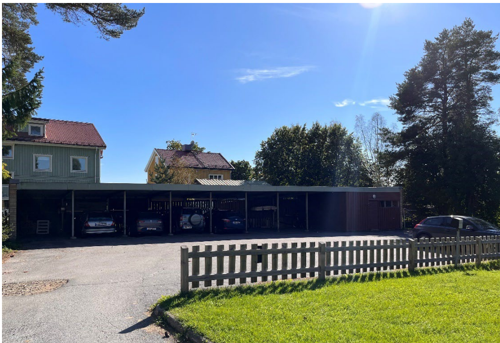
Figur 20. Befintlig parkering inom fastigheten
