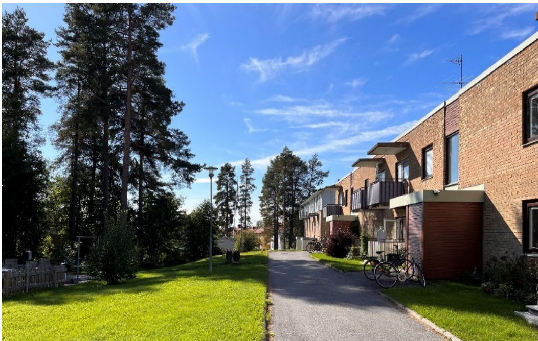
Figur 11. Befintlig innergård för fastigheten Vindfället 9.
