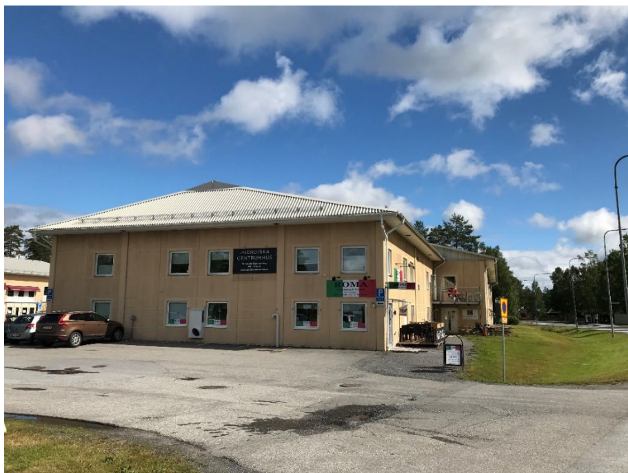
Figur 7. Befintlig byggnad inom planområdet.
