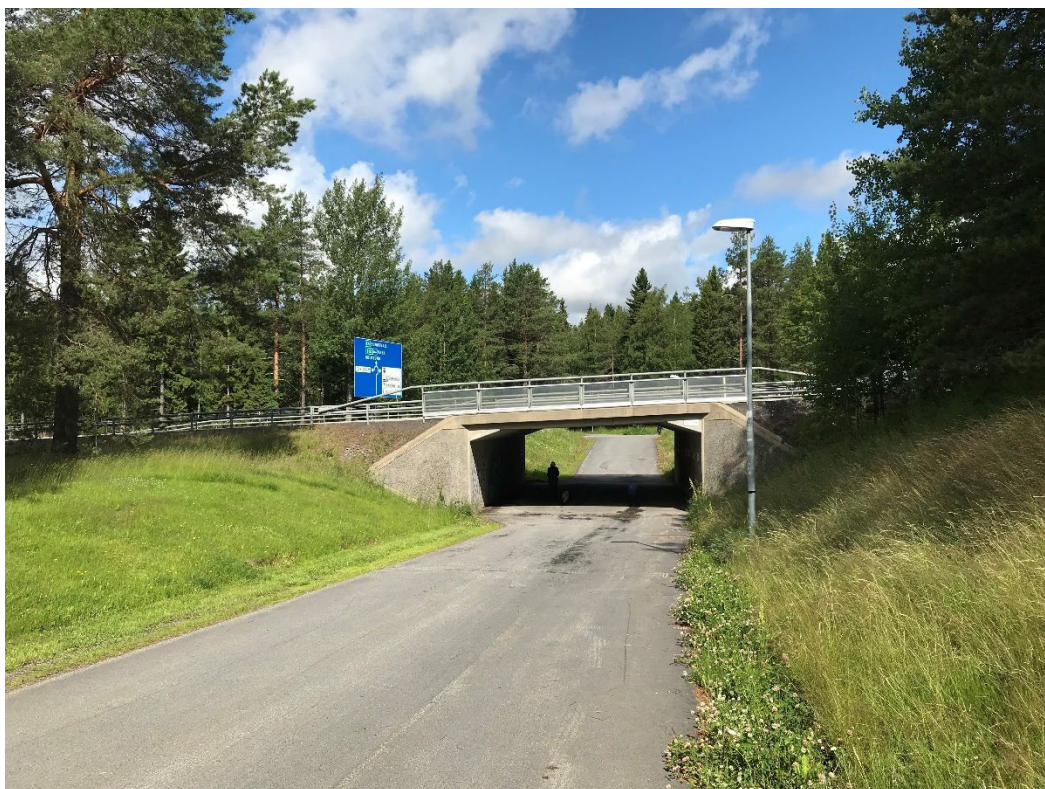
Figur 14. Gång- och cykelväg väster om planområdet som leds i en tunnel under väg E4.
