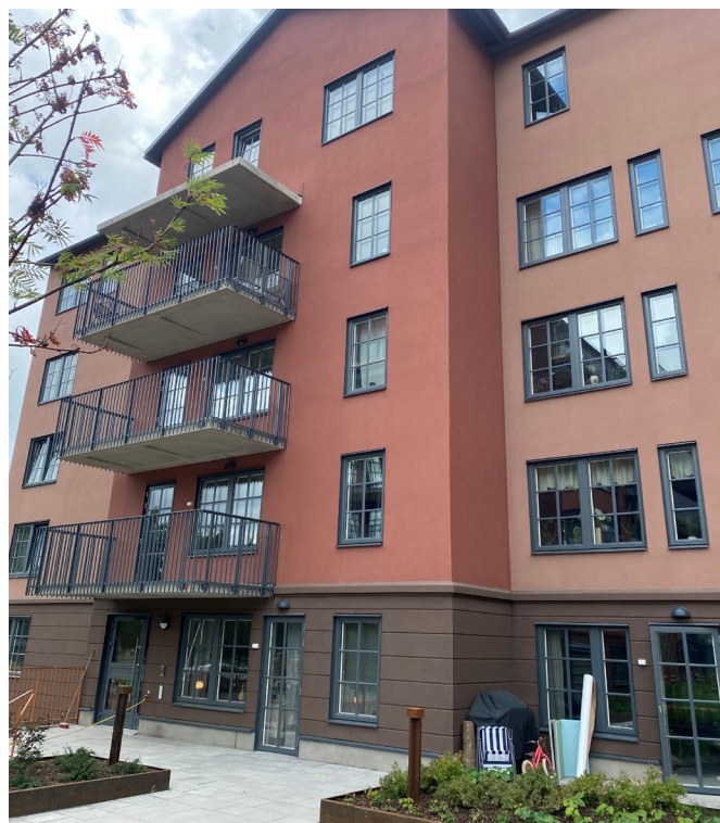
Utkragande balkonger som inte upptar för stor del av fasaden, Umeå kommun Teg.
