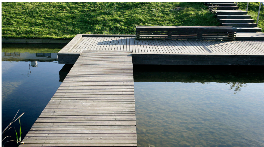
Dagvattensystem Malmö. Källa: https://sydvast.se/projekt/vinriediket/ foto: Marja Diaz
