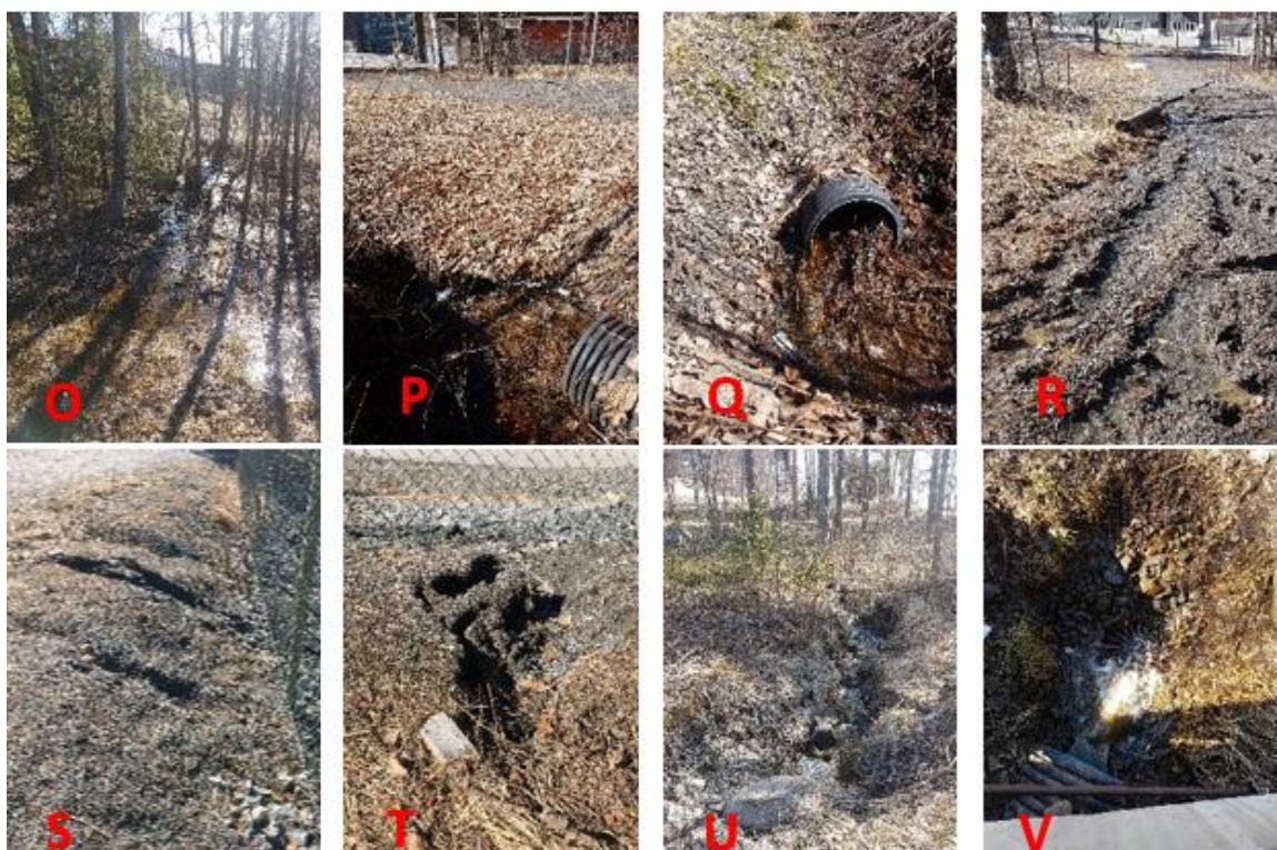
Figur 11. Område öst/sydöst om Umeå energi arena.
