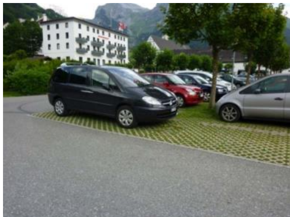
Figur 24. Parkeringsyta belagd med gräsarmering. Bilden är tagen från Annika Ritzmans exjobb om ämnet, fotograf Brita Svensson 2011.
