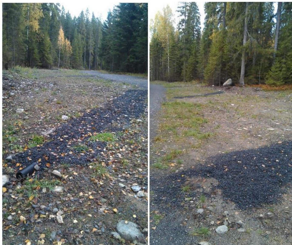
Figur 28. Flödesavskärande dränering i 12-metersspåret (Tyréns, 2014).
