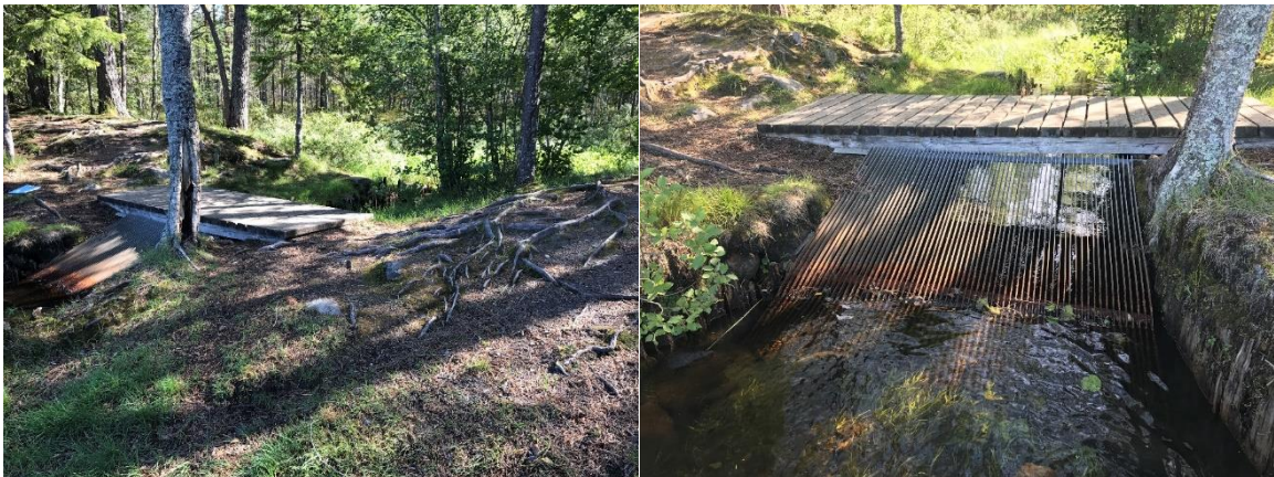
Figur 33. Den gamla dammvallen vid delsträckans slut med ett galler vid utskovet.
