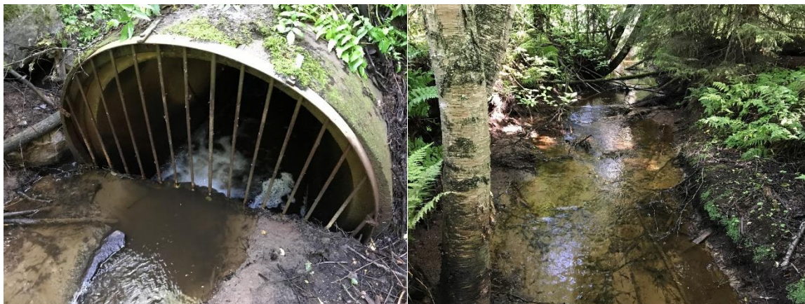
Figur 22. Gallret till kulverten hindrar all eventuell uppvandring av fisk i Kolbäcken. Naken finsedimentjord utgör till stor del strandzon på delsträcka 1.
