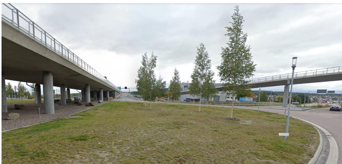
Exempelbild E4 på bro, ramp söderut. Cirkulationsplats norr om Sundsvallsbron.
