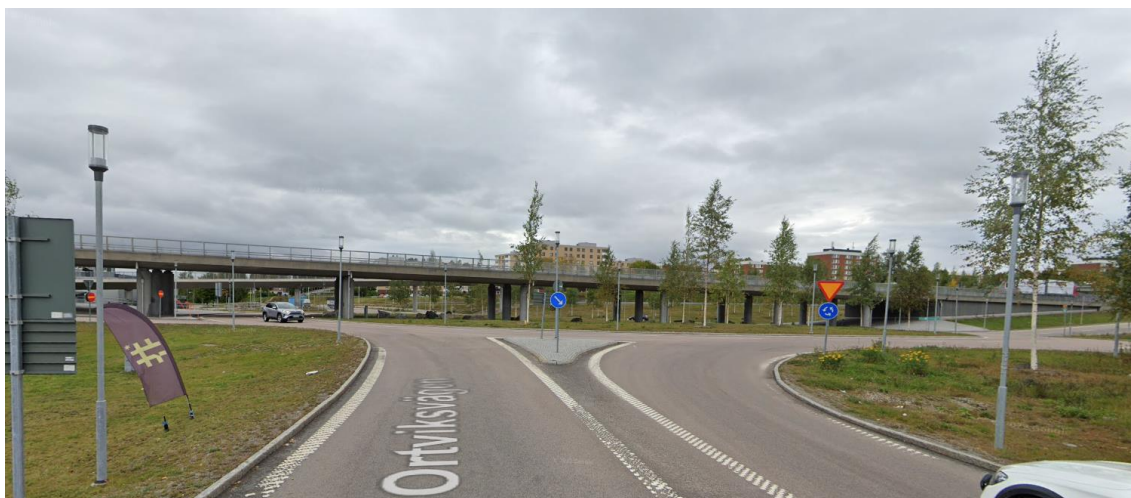
Exempelbild E4 på bro, lokalgator på marknivå radie 47 meter, Ortviksvägen norr om Sundsvallsbron.
