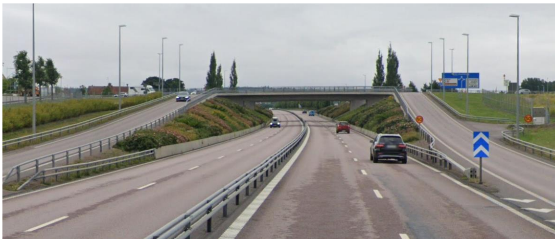
Exempelbilder på planskild korsning med cirkulation på bro, väg 50 och väg 34, Motala, radie cirka 33 m
